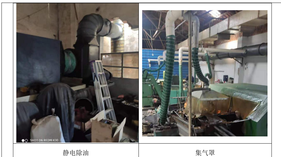
图 3-3 企业废气处理设施照片
